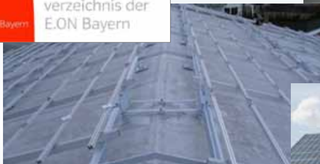
Professionelle Montage der Unterkonstruktion auf einem Schweißbahndach
