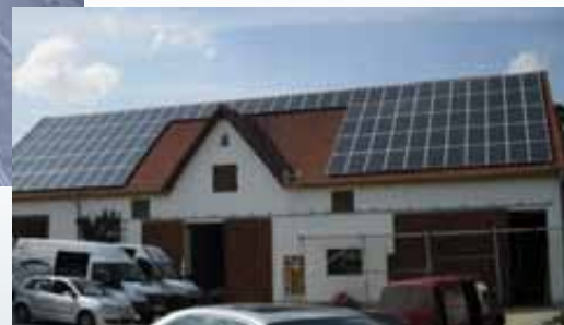
Aufdachmontage auf einem Ziegeldach
